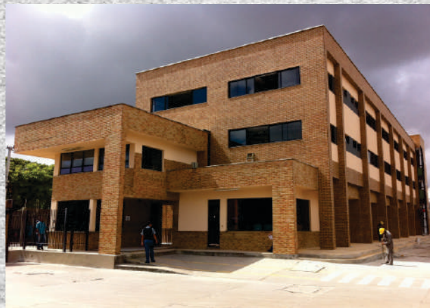
YPIÓCA - PRÉDIO ADMINISTRATIVO Edifício em Estrutura Pré-fabricada
