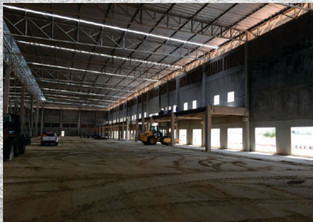
FP PARTICIPAÇÕES Galpão com Mezanino em Estrutura e Painéis Pré-fabricados
