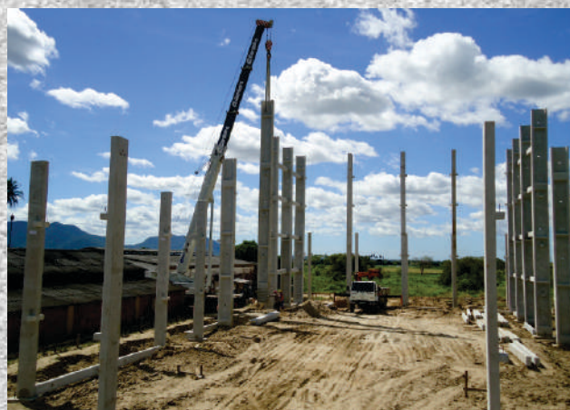
YPIÓCA - IPARK Edificação em Estrutura Pré-fabricada
