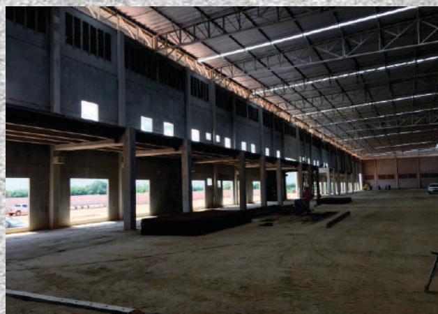
FP PARTICIPAÇÕES Galpão em Estrutura e Painéis Pré-fabricados
