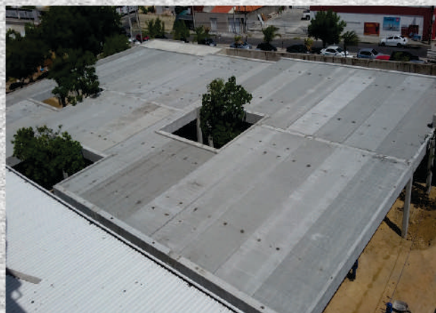
COLÉGIO ARI DE SÁ Edificação em Estrutura e Laje Pré-fabricada
