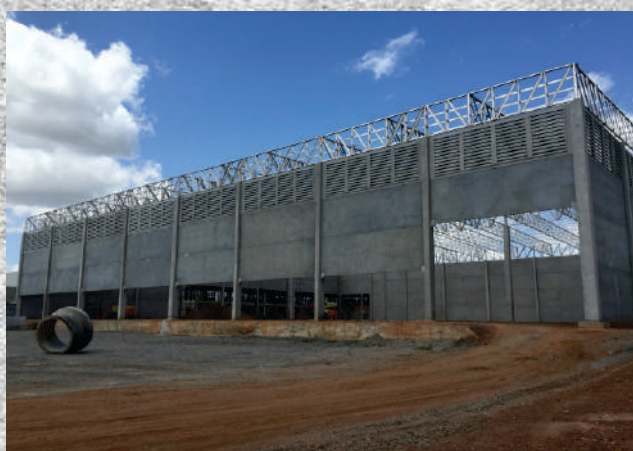
TEDA LOGÍSTICA Galpão em Estrutura e Painéis Pré-fabricados
