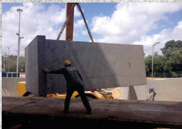
JCC - SHOPPING IGUATEMI Muro de Arrimo Pré-fabricado
