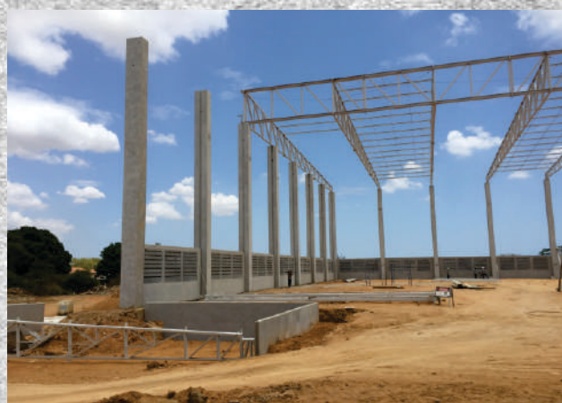
CASAS FREITAS Galpão em Estrutura e Painéis Pré-fabricados
