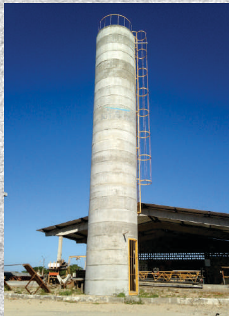
CAIXA D'ÁGUA - TIPO 2 Diâmetro interno= 2.00m - Cap. máx. 30.000 L Diâmetro interno= 3.00m - Cap. máx. 50.000 L
