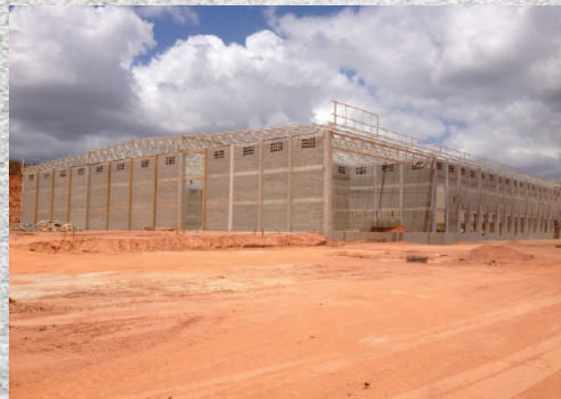
COMERCIAL IBIAPINA - GALPÃO 03 Galpão em Estrutura e Muros de Arrimo Pré-fabricado
