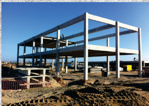
CMM - COMPANHIA SIDERÚRGICA DO PECÉM Edificação em Estrutura e Laje Pré-fabricada
