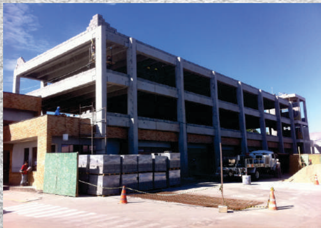
YPIÓCA - PRÉDIO ADMINISTRATIVO Edifício em Estrutura Pré-fabricada
