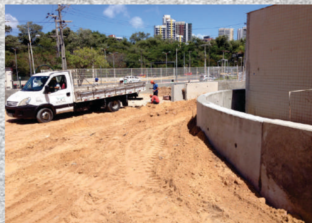
JCC - SHOPPING IGUATEMI Muro de Arrimo Pré-fabricado
