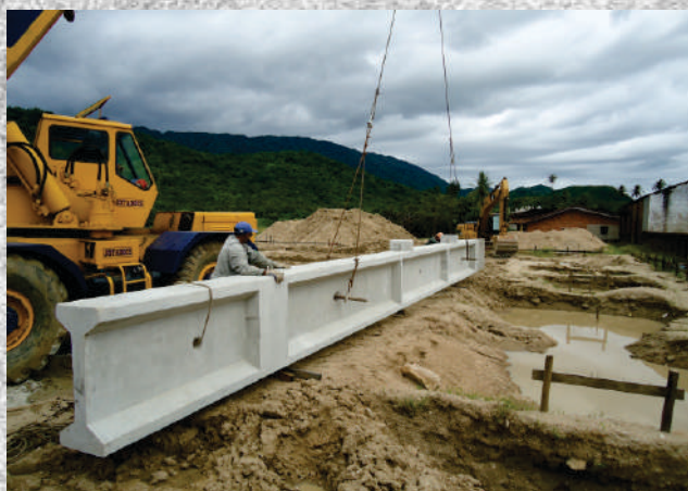
YPIÓCA - IPARK Edificação em Estrutura Pré-fabricada
