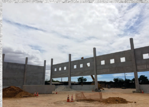
SAMLOG II Galpão em Estrutura, Painéis e Muros de Arrimo Pré-fabricados
