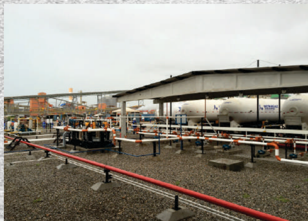
ULTRAGAZ Galpão em Estrutura e Painéis Pré-fabricados
