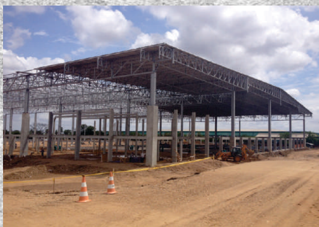
CORTEZ - GRENDENE Galpão em Estrutura Pré-fabricada
