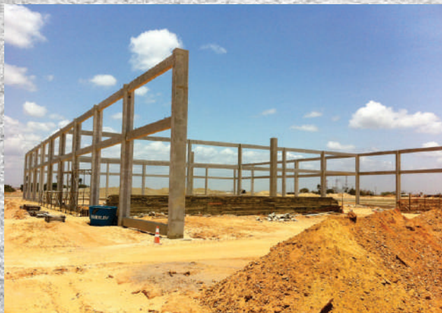
CORTEZ - COMPANHIA SIDERÚRGICA DO PECÉM Edificação em Estrutura Pré-fabricada
