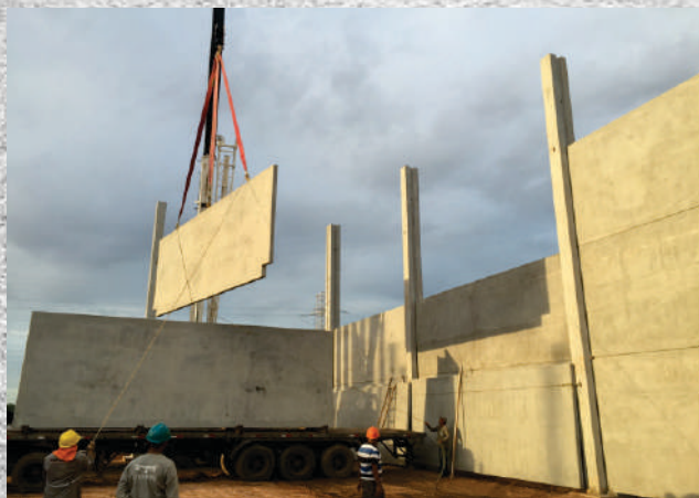
MONTAGEM DOS PAINÉIS PRÉ-FABRICADOS Galpão em Estrutura e Painéis Pré-fabricados
