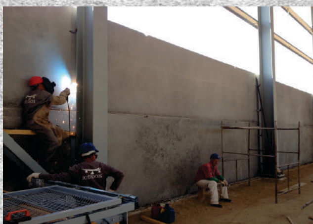
SILAT Galpão em Estrutura Metálica com Fechamento em Painéis Pré-fabricados
