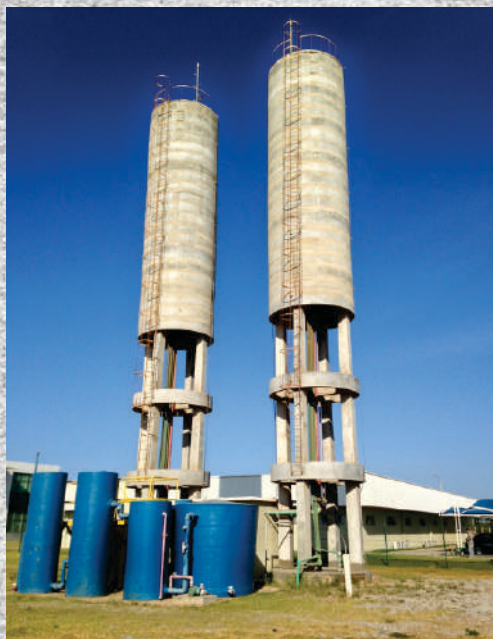
CAIXA D'ÁGUA - TIPO 1 Diâmetro interno= 3.00m - Cap. máx. 50.000 L
