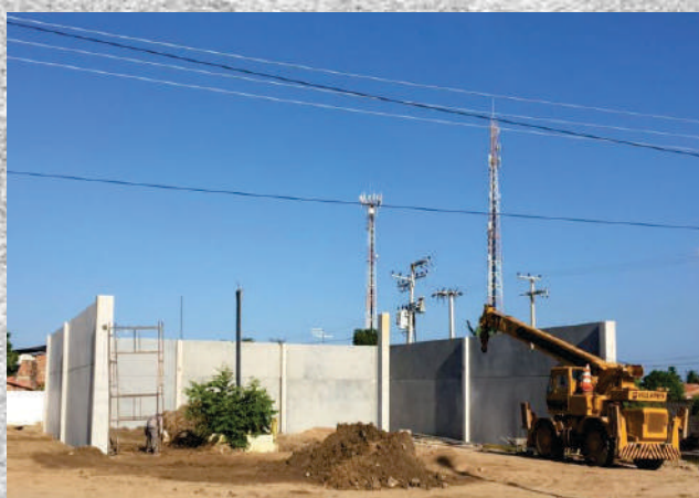
POSTO SIM Galpão em Estrutura e Painéis Pré-fabricados
