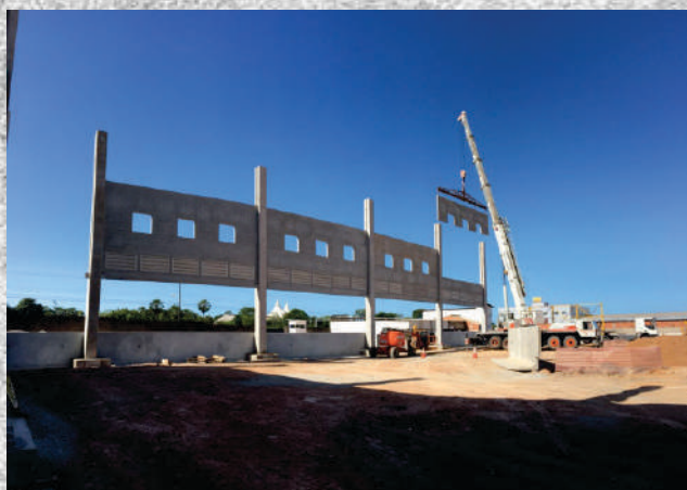
SAMLOG II Galpão em Estrutura e Painéis Pré-fabricados
