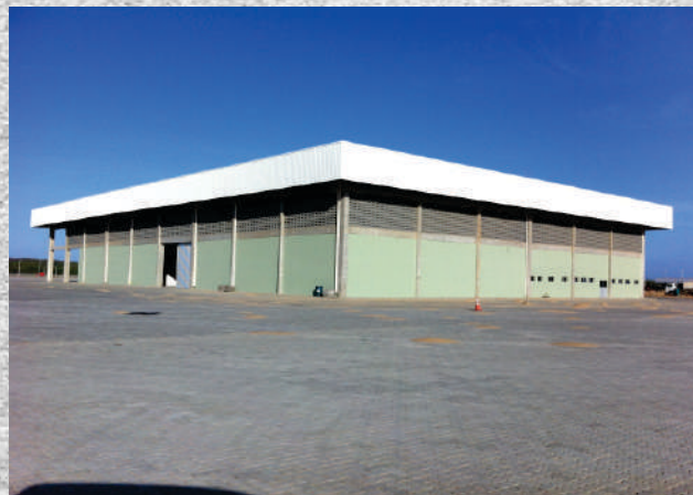
CORTEZ - COMPANHIA SIDERÚRGICA DO PECÉM Galpão em Estrutura Pré-fabricada
