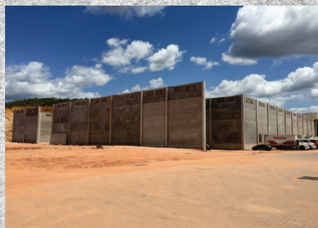
COMERCIAL IBIAPINA - GALPÃO 09 Galpão em Estrutura e Painéis Pré-fabricados
