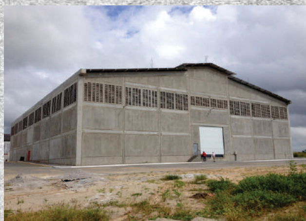
YPIÓCA - DIAGEO Galpão em Estrutura e Painéis Pré-fabricados
