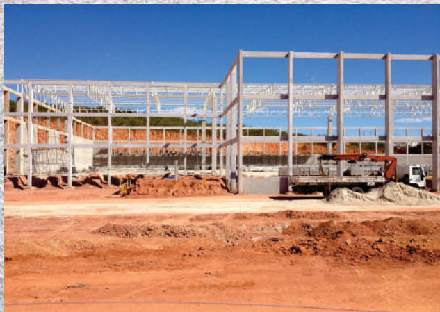
COMERCIAL IBIAPINA - GALPÃO 03 Galpão em Estrutura e Muros de Arrimo Pré-fabricados
