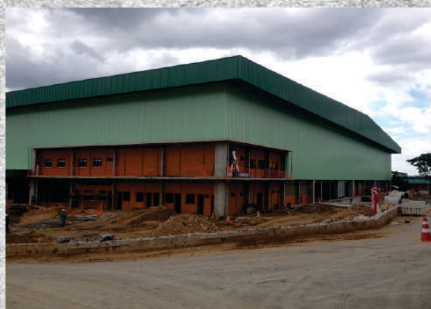
CORTEZ - GRENDENE Galpão em Estrutura Pré-fabricada
